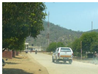
Figura 47 – Workshop sobre TIC, Antena de Telecomunicações em Guro
