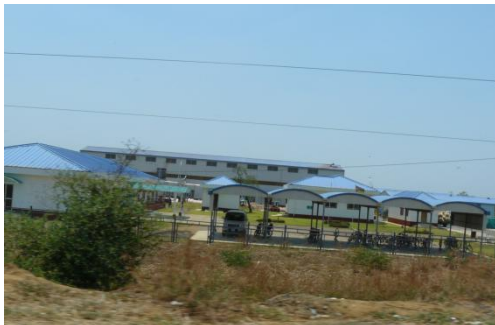
Figura 36 – Fábrica de Descaroçamento (OLAM AVZ)
