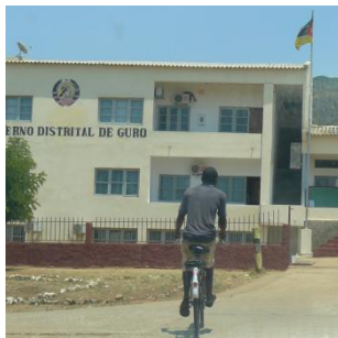
Figura 21 – Edifício do Governo Distrital
